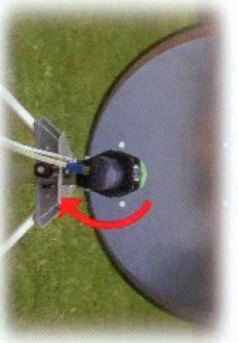
Skew: → draai LNB rechtsom in de houder + → draai LNB linksom in de houder
